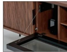
適度な抵抗を感じさせながらゆっくりと開閉するドロップダウン扉。高品質のワイヤーステーやソフトダンパーの採用で、より滑らかな操作性を追求しています。納まりや目立ちにくさを重視したパーツ類を使用し、機能的ですっきりしたデザインに仕上げています。
